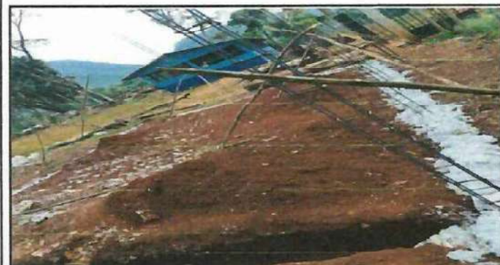
Foto 3: Así se observa en otro ángulo que serán las columnas del trabajo.
