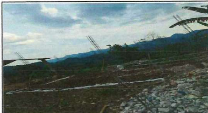
Foto 4: Con este trabajo se continuará la ampliación de las aulas.
